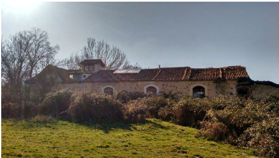
Fachada norte. A la izquierda la vivienda, a continuación la zona de taller y a la derecha vista parcial de la zona de actuación.
