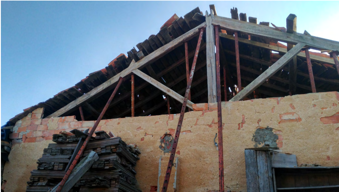
Vista de otra cercha de madera, con un cerramiento intermedio de fábrica.
