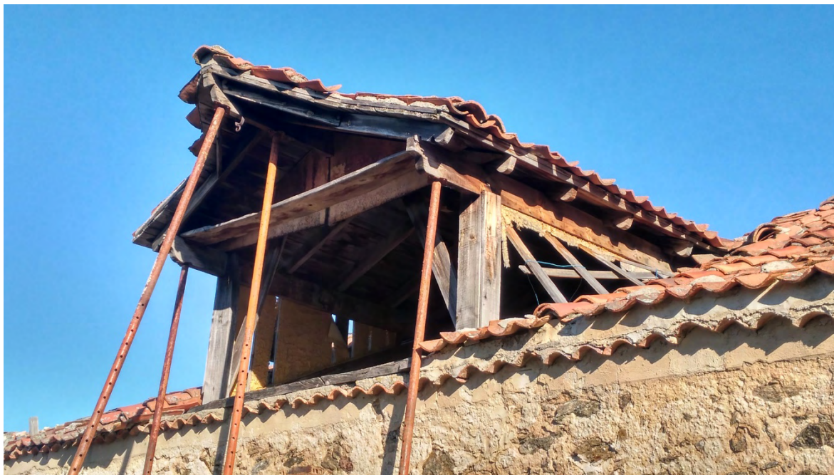
Detalle exterior de la mansarda sobre la cubierta
