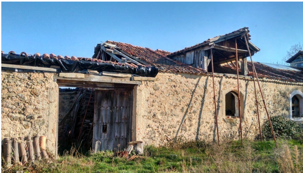
Puerta de acceso y mansarda sobreelevada respecto de la cubierta.
