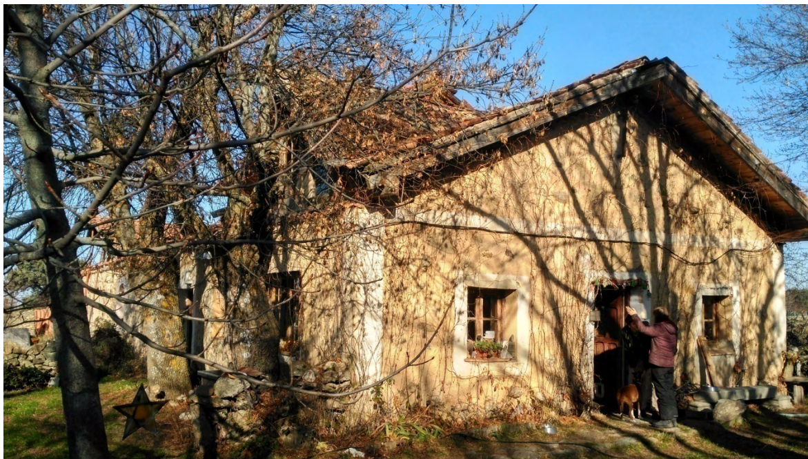
Fachada este correspondiente a la vivienda y su acceso.
