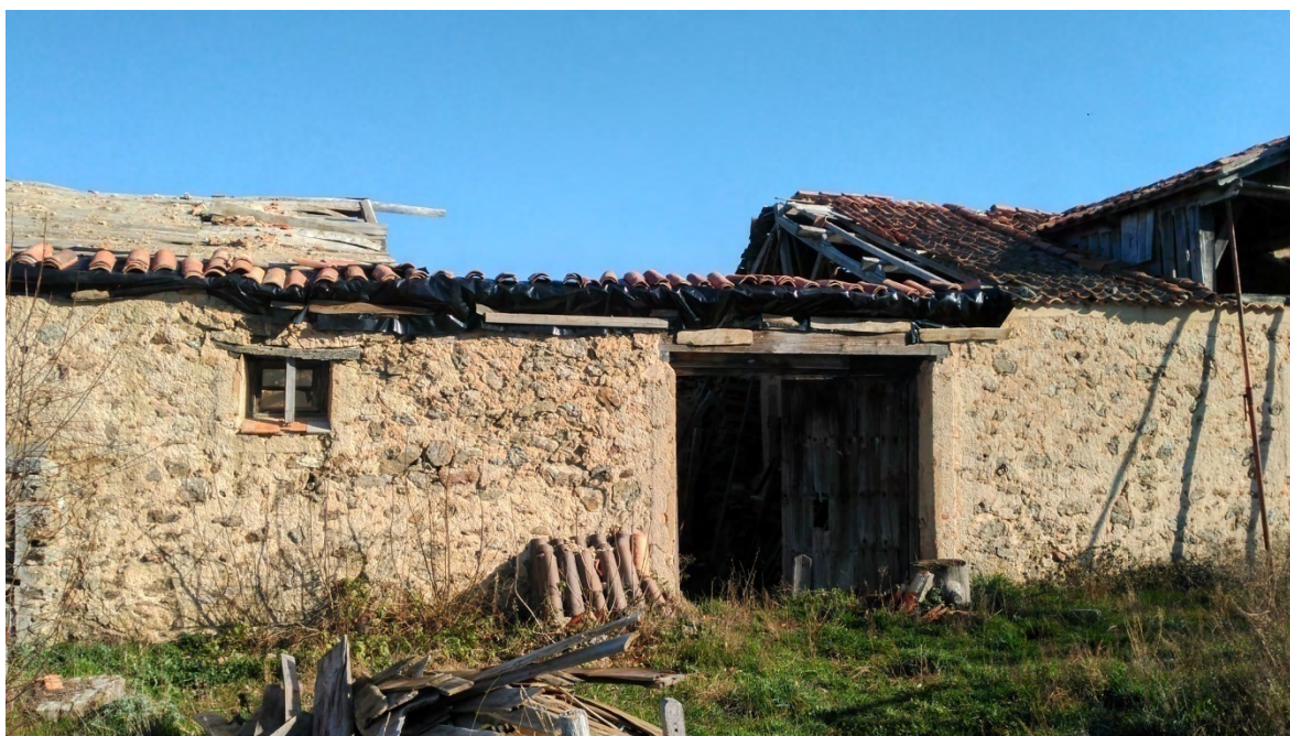
Zona de acceso a la zona objeto de la reconstrucción de cubierta.
