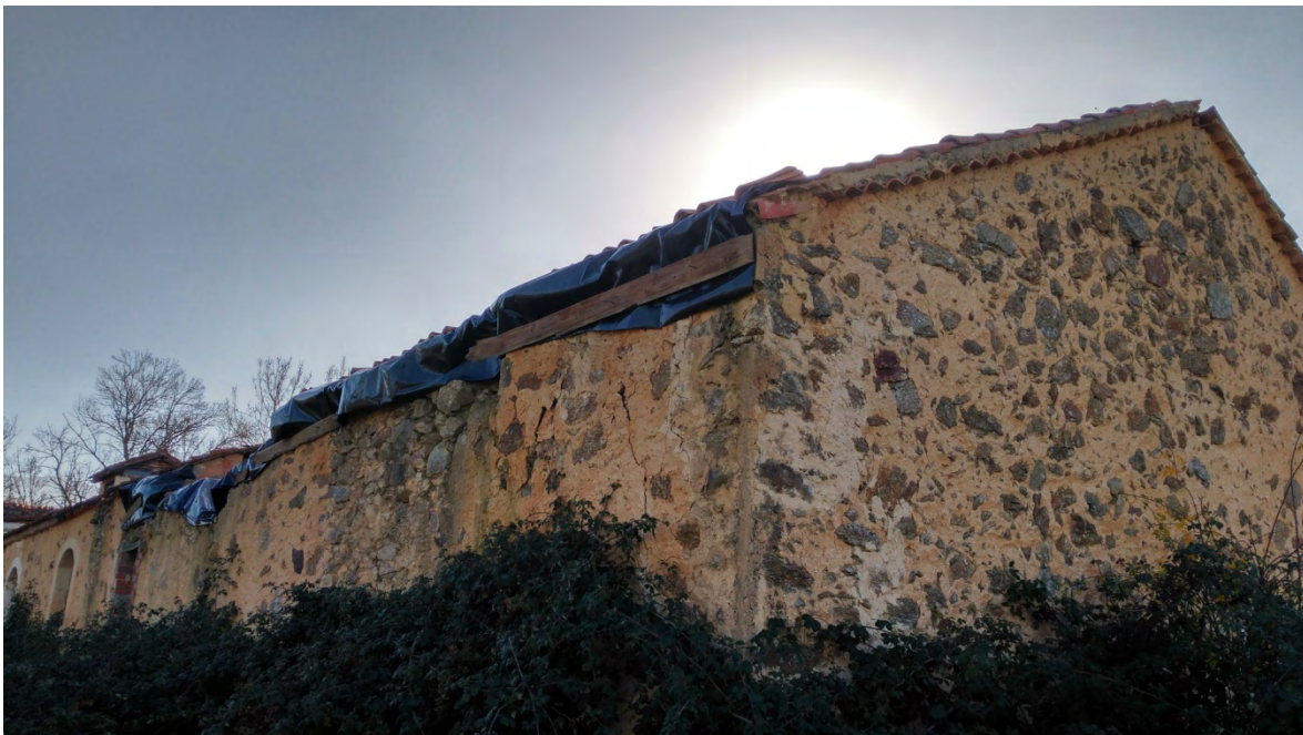
Fachada norte y oeste del volumen a reconstruir.
