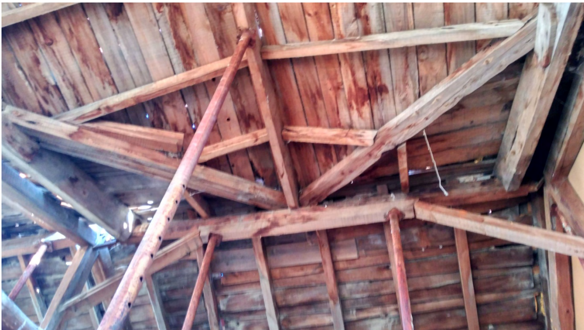
Detalle del entramado de madera y rípias
